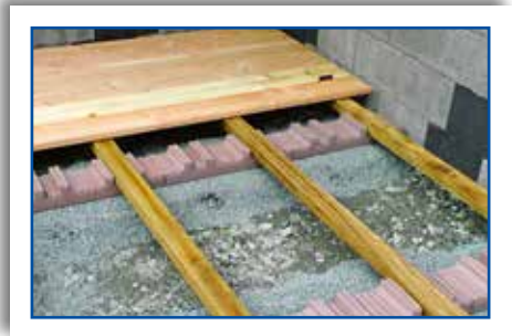
Aufbau mit dem Streifen-Fundamentstein:
